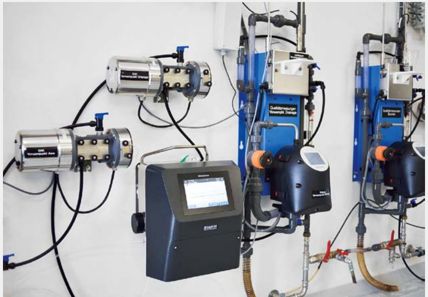
Fig. 1 BactoSense integriert in die Online-Analysewand der Grundwasserpumpstation Köniz (mit freundlicher Genehmigung von Bruno Boss, Wasserversorgung Köniz)
